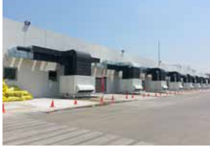
Eldor Elektrik Fabrikası - İzmir
