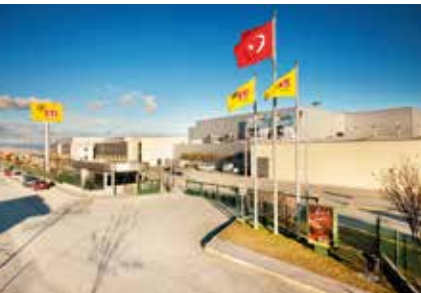
Eti Fabrikası Sosyal Tesisler - Eskişehir
