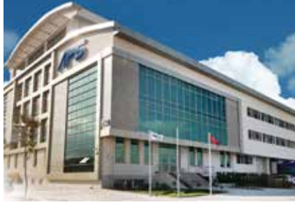
AFS Boru Fabrikası - Ankara
